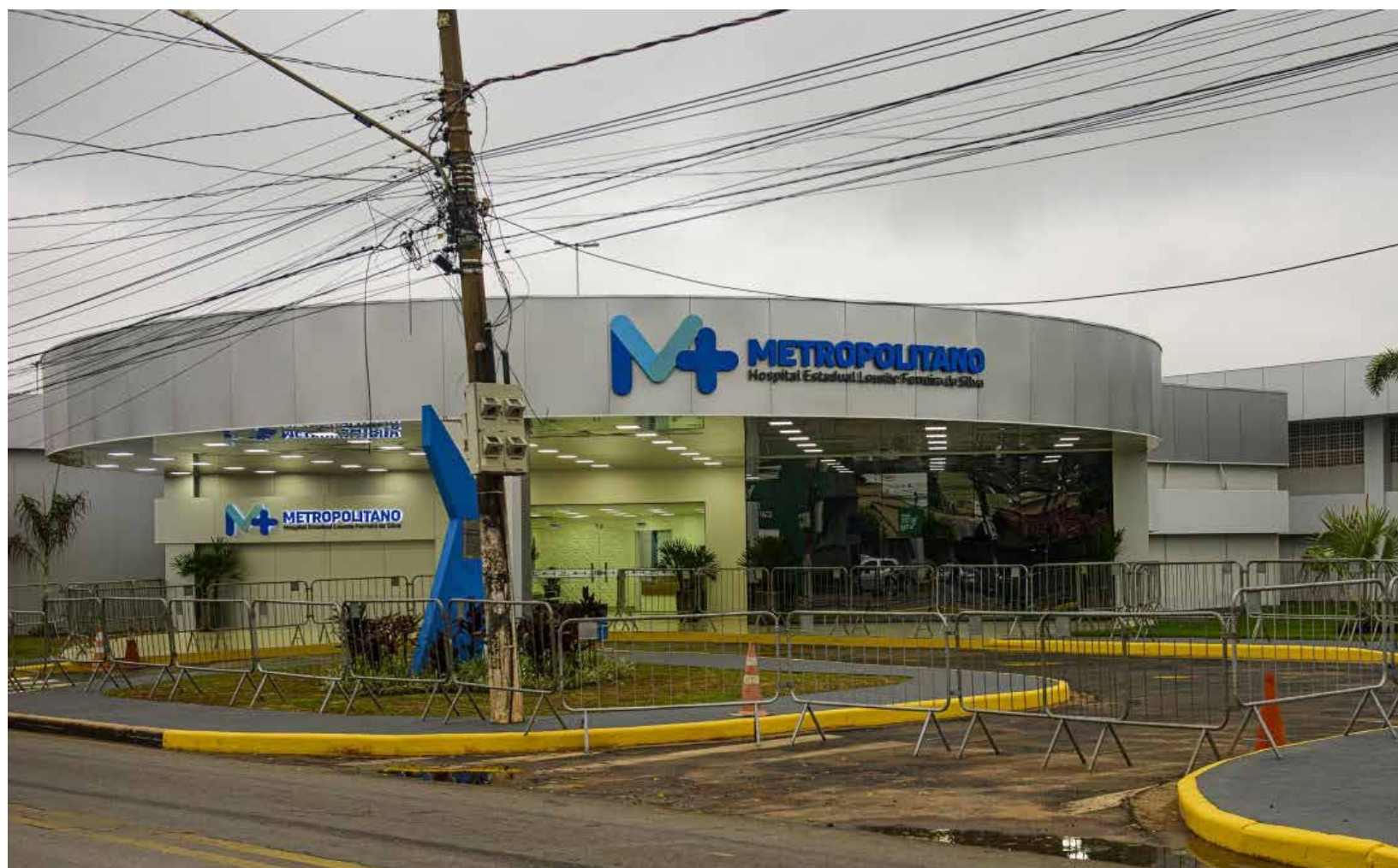
SES suspendeu temporariamente as visitas e a presença de acompanhantes nos hospitais geridos pelo Estado
