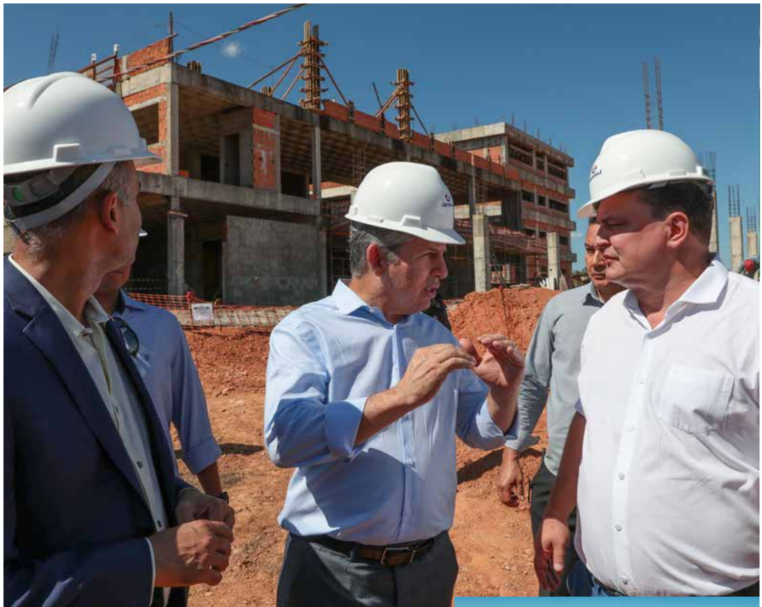
Governador Mauro Mendes realiza visita técnica às obras do Hospital Júlio Müller
