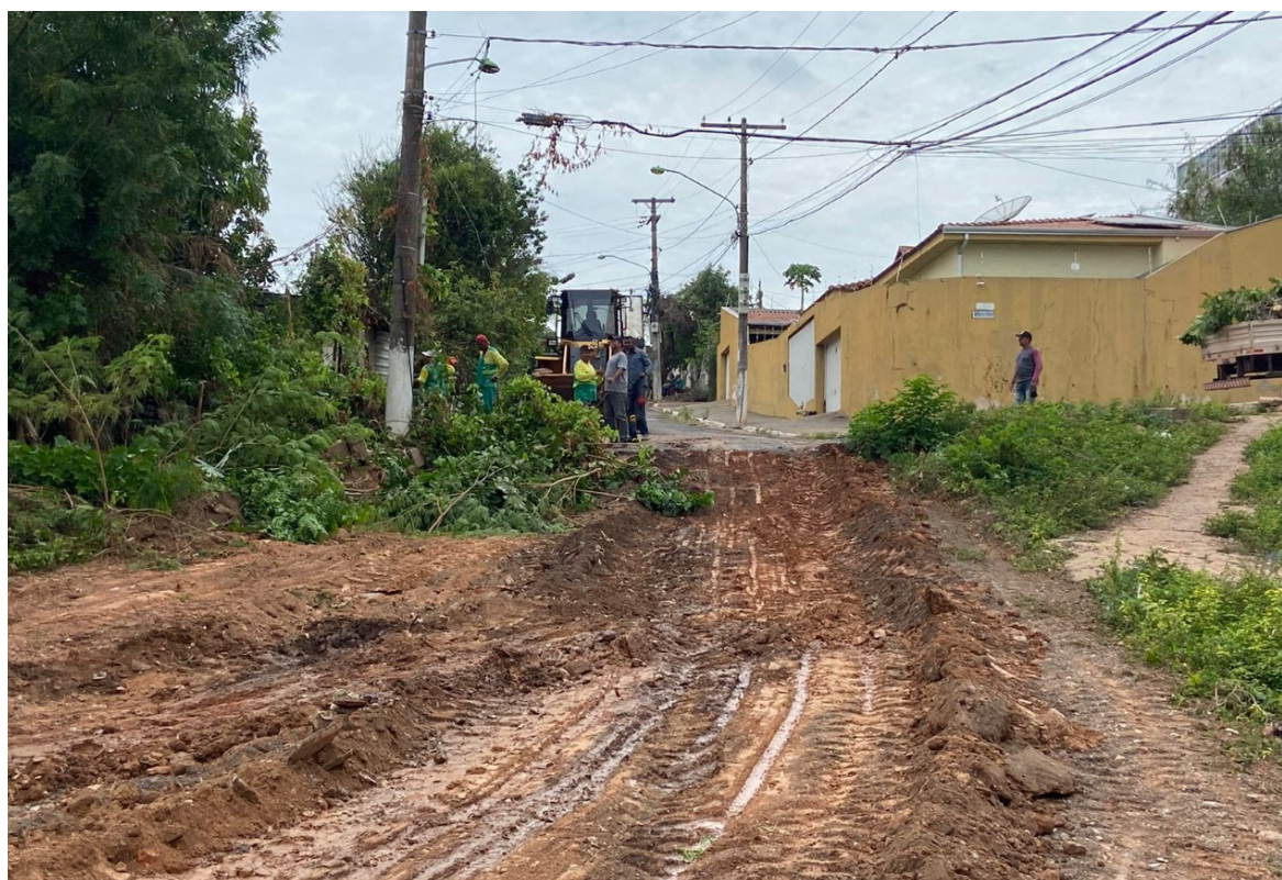
Máquinas da Secretaria Municipal de Obras já iniciaram os trabalhos de pavimentação asfáltica
