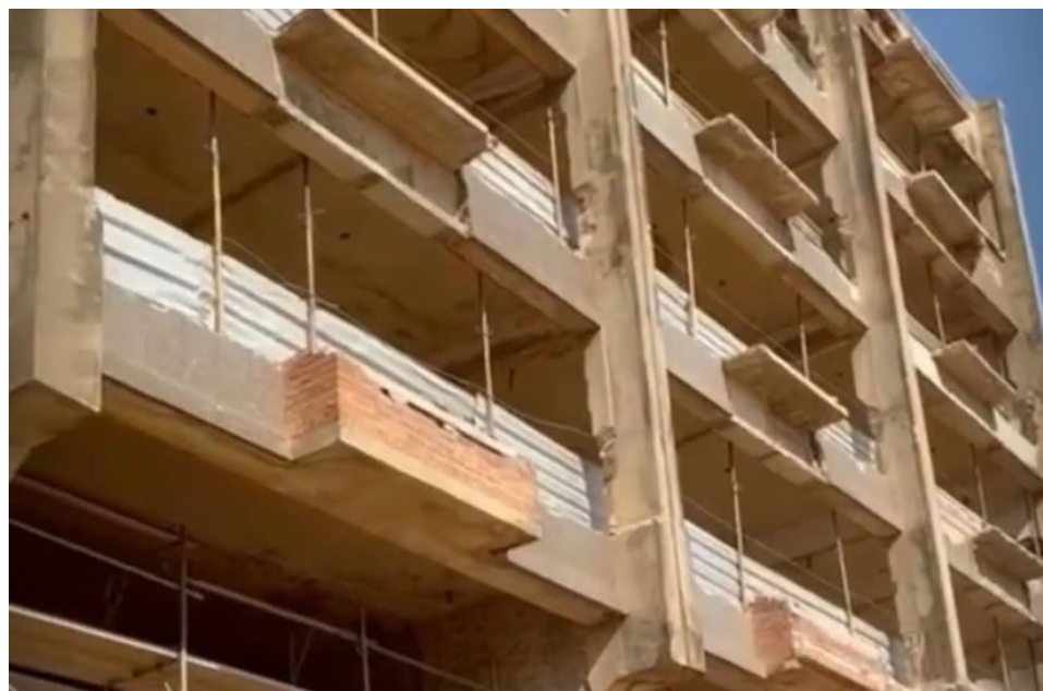
A obra prevê um acréscimo de 23 mil m 2 à estrutura antiga, sendo que a unidade hospitalar contará com um total de 32 mil m 2 de área construída
