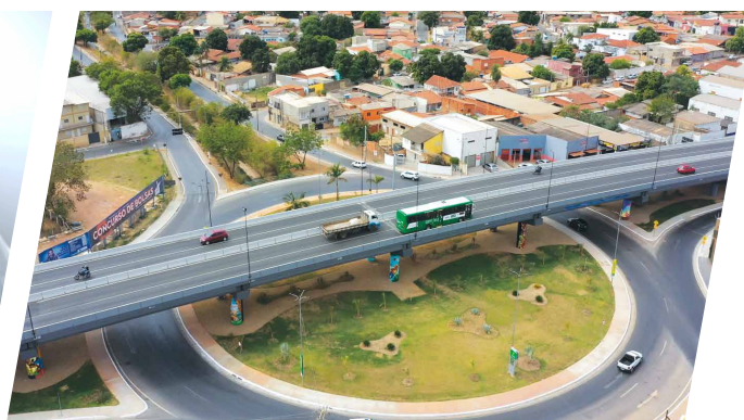
Faixas exclusivas de ônibus e dois novos viadutos.
