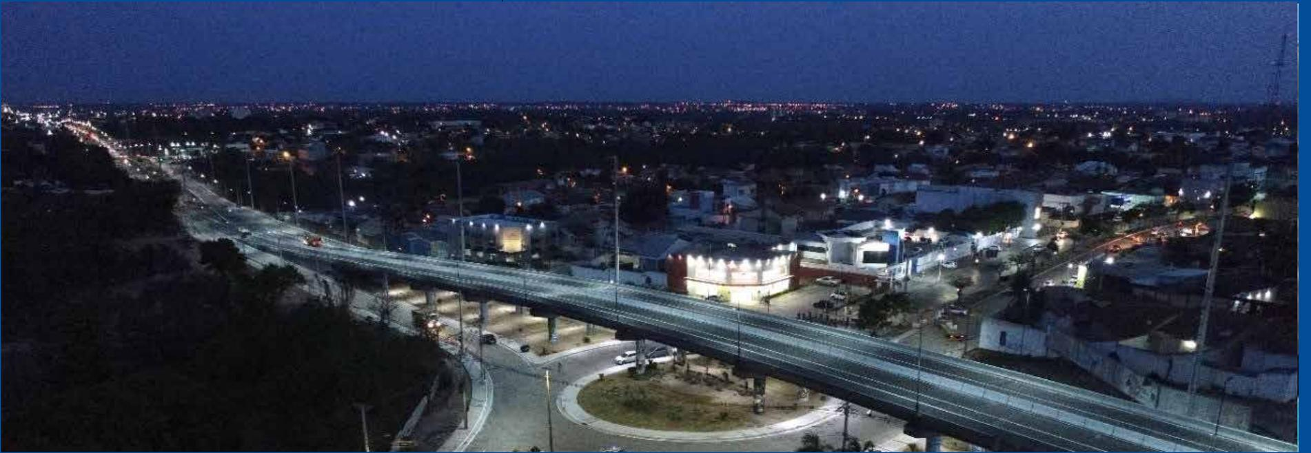
O viaduto possui 200 metros de comprimento, 18 metros de largura, e aproximadamente 150 metros de muro de terra armada
