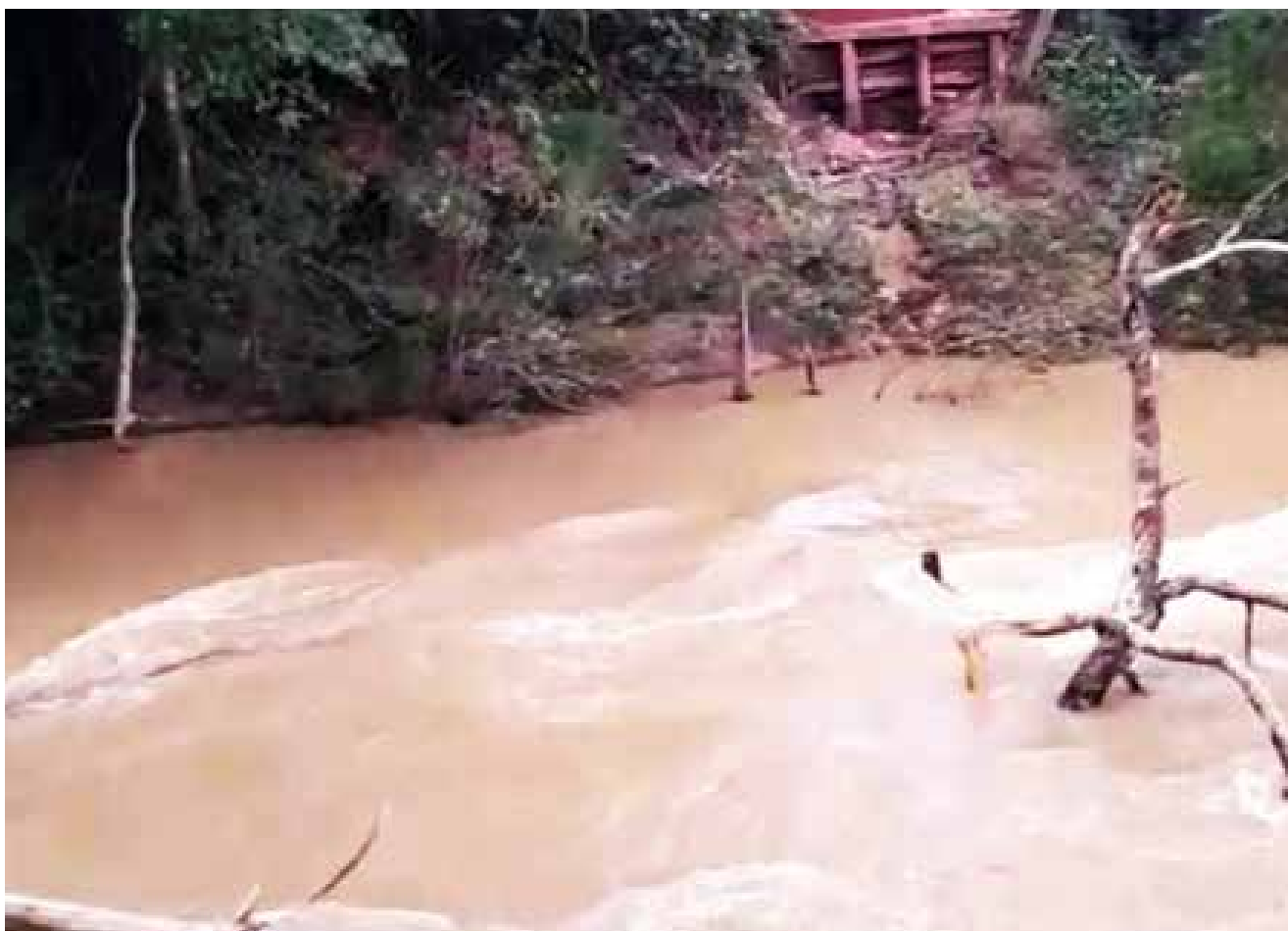
Ponte sobre Rio Sangradouro Grande (divisa de Livramento com Poconé e Cáceres), logo após ser levada pelas chuvas em 2018
